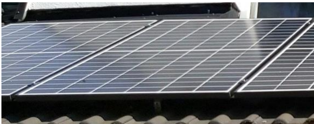
Zdjęcie paneli fotowoltaicznych
