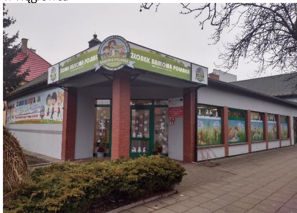
Rys. 5. Budynek Żłobka „Bajkowa Polanka zwi wędrowcy” w Wągrowcu
