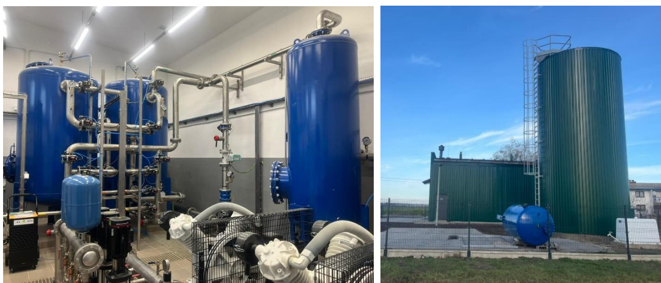
Rys. 2. Wodociąg Trębaczów (powiat kępiński)
