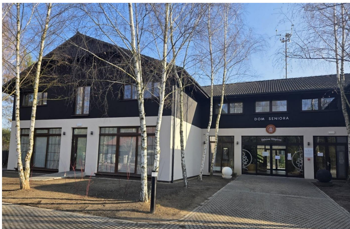
Rys. 3. Dom Seniora w Dębogórze
