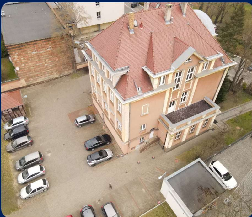
Przebudowa i rozbudowa Willi
