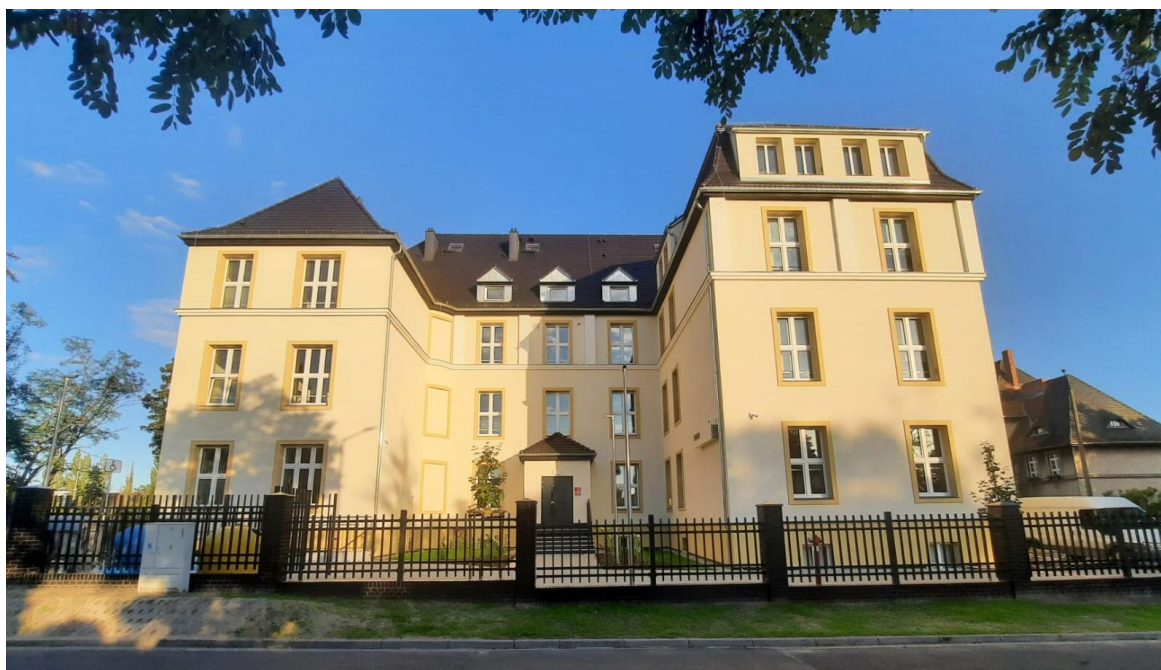
Modernizacja budynku WSCKZiU w Rawiczu, źródło: DE
