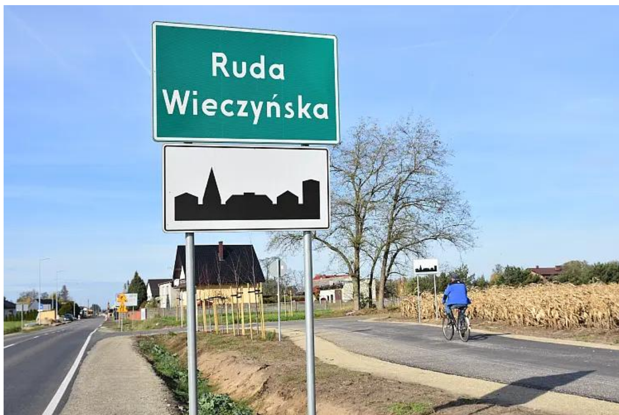
Rozbudowa drogi wojewódzkiej nr 442 w powiecie pleszewskim Źródło: WZDW
