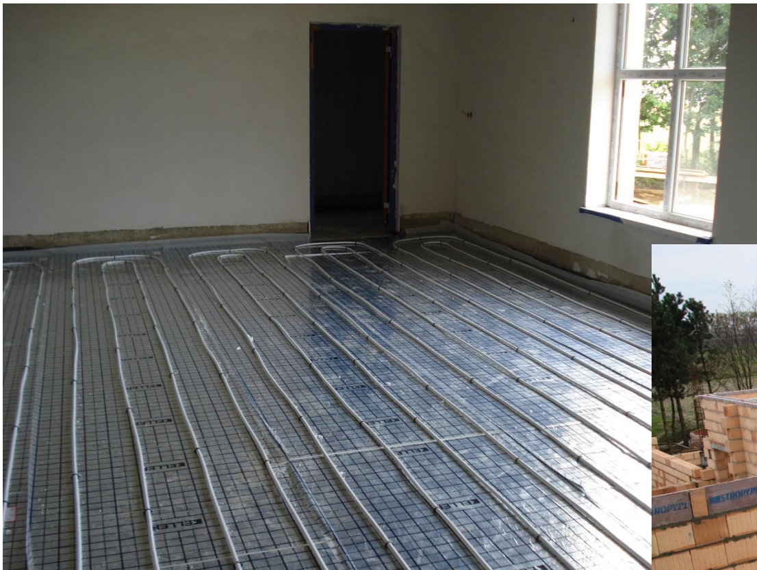
Układanie ogrzewania podłogowego
