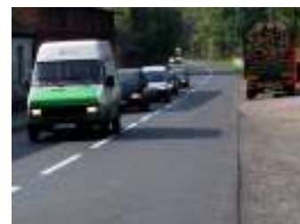
odnowa nawierzchni drogi wojewódzkiej nr 434 w m. Śródka – po remoncie
