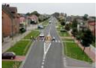
przebudowa ul. Powstańców Wlkp. m. Drawsko
