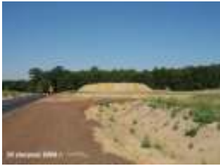
Obwodnica m. Kórnik(droga 4343) - budowa ronda
