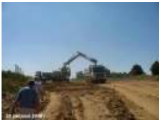
Obwodnica m. Śrem -prace ziemne
