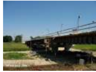
Obwodnica Śrem na kanale Ulgi
