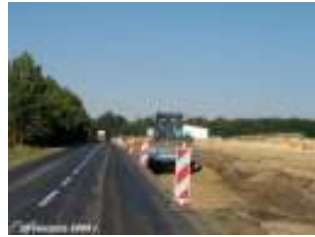
Obwodnica m. Kórnika poszerzanie drogi
