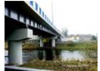
Przebudowa mostu - Wieleń
