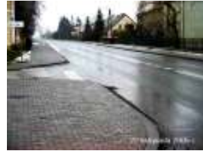
Odnowa nawierzchni drogi nr 442
