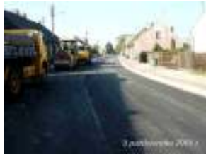
Przebudowa drogi nr 190
