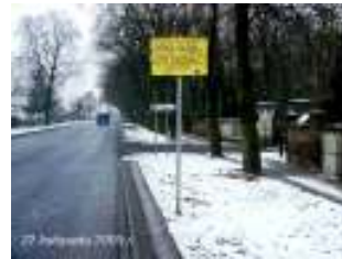
Przebudowa drogi nr 466 i 467
