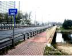
Remont mostu w Pile
