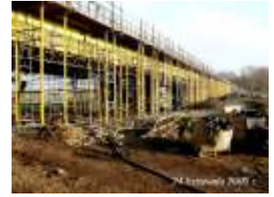
Remont mostu w Międzychodzie
