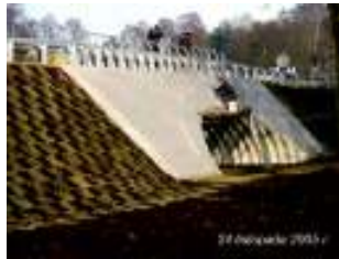
Rozbiórka mostu w m. Zatonia Stary
