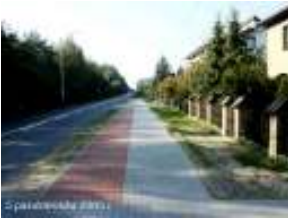
Remont drogi nr 241 Wagrowiec
