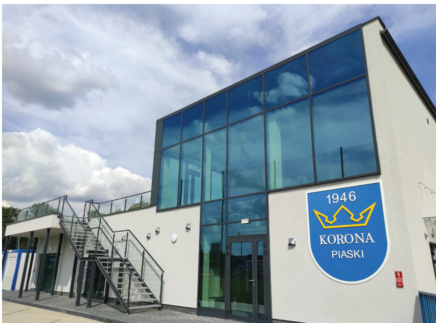
Fot. 4. Gmina Piaski – obiekt w programie „Szatnia na Medal” po remoncie (Źródło Urząd Gminy Piaski)
